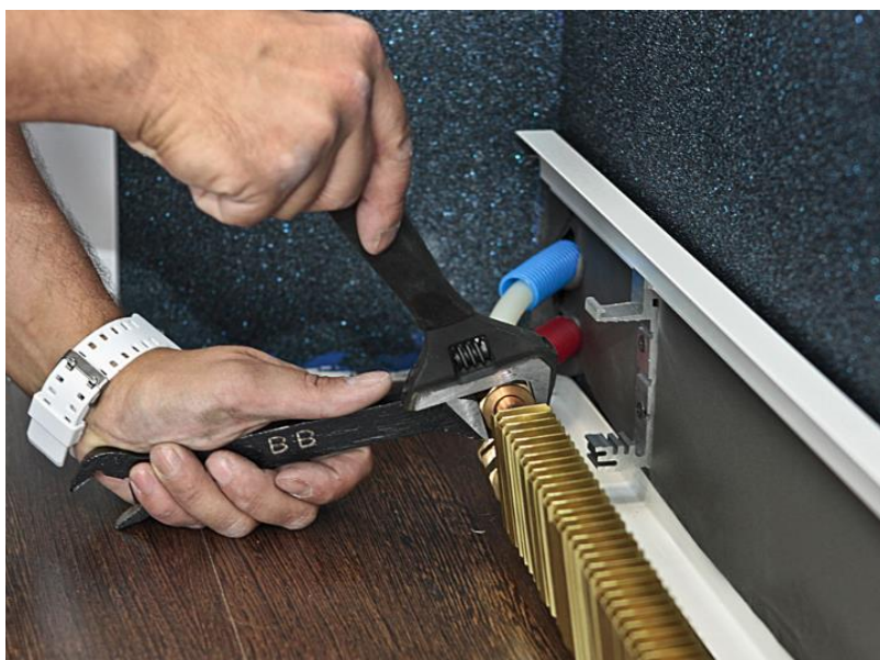
Рис. 24. Окончательный обжим.
