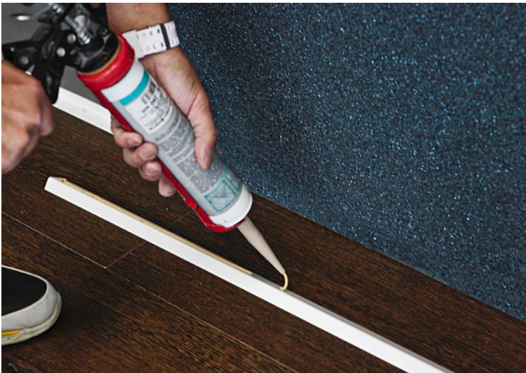
Рис. 6. Установка нижней планки на клей.
