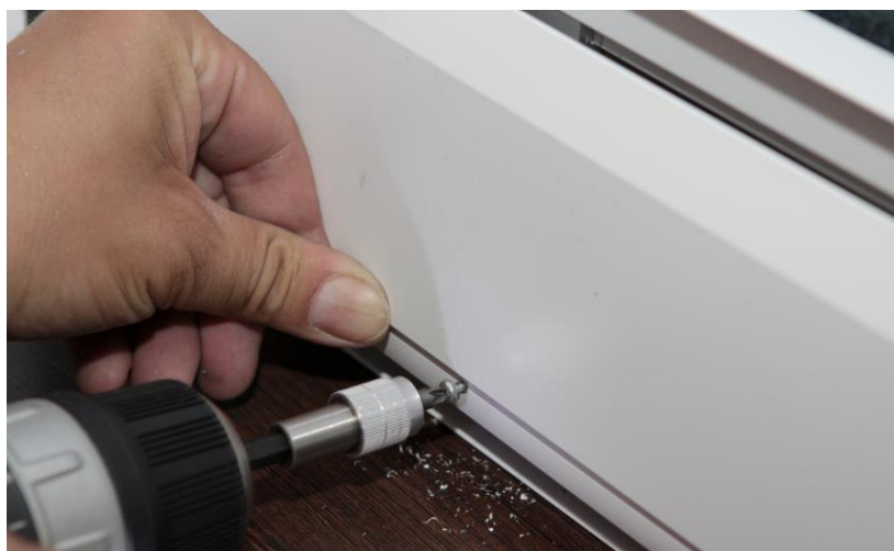
Рис. 34. Крепёж закрывающей планки.
