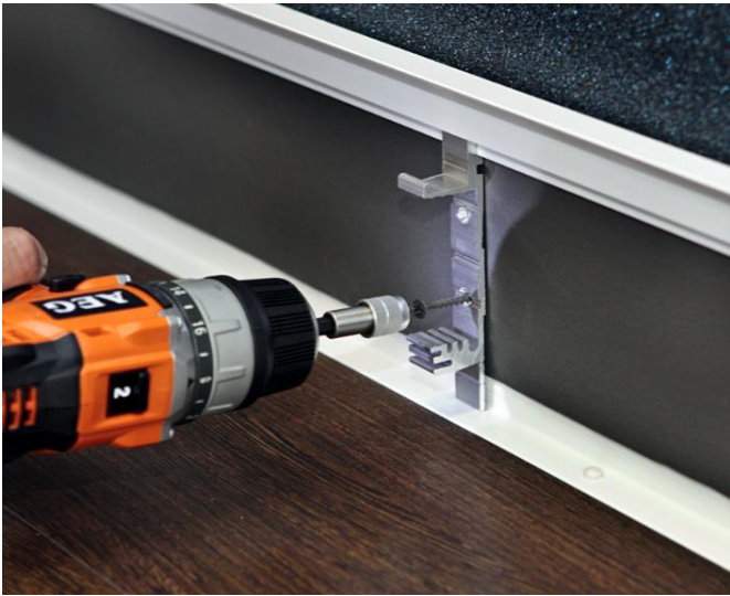
Рис. 17. Головки саморезов не должны торчать.
