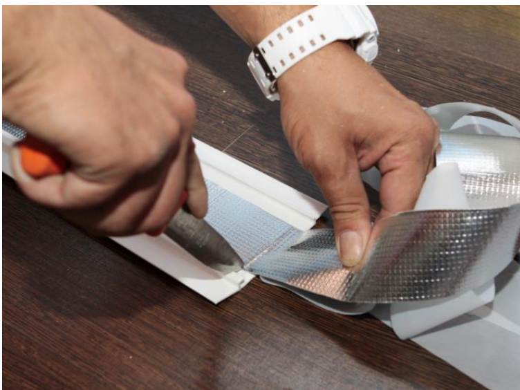
Рис. 32. Край ленты подрезается.
