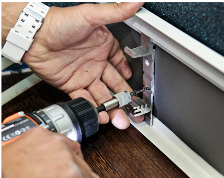
Рис. 16. Крепеж верхней планки с
