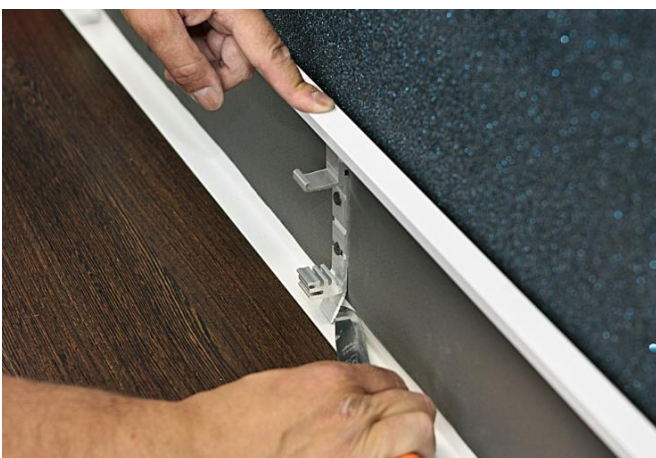
Рис. 19. Удаление нижней части кронштейнов –
