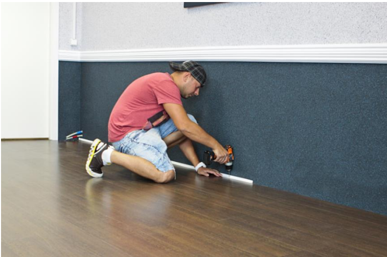
Рис. 5. Установка нижней планки на
