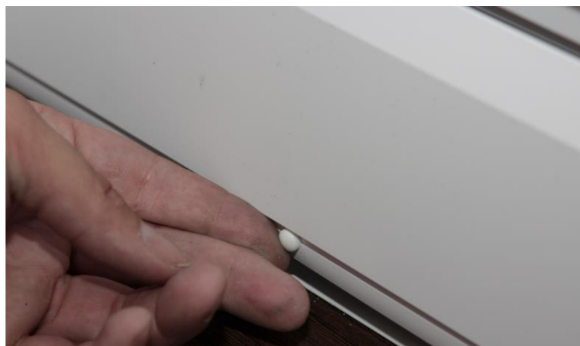
Рис. 35. Головки шурупов закрываются декоративными колпачками.
