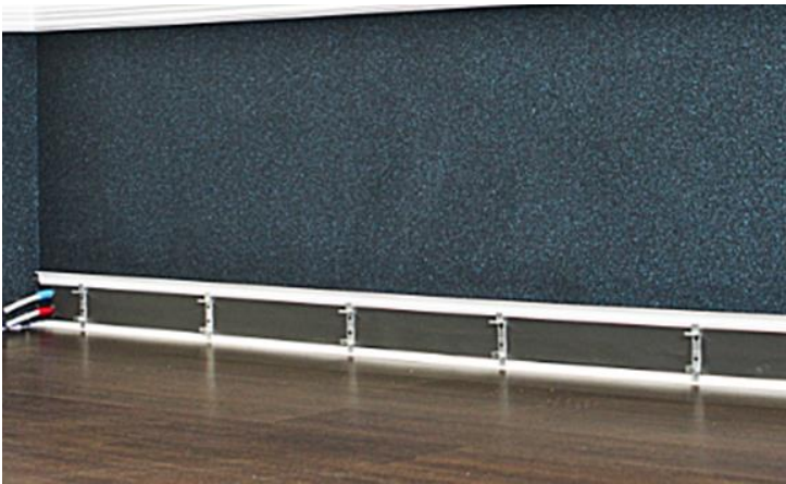
Рис. 18. Смонтированные линейные элементы –
