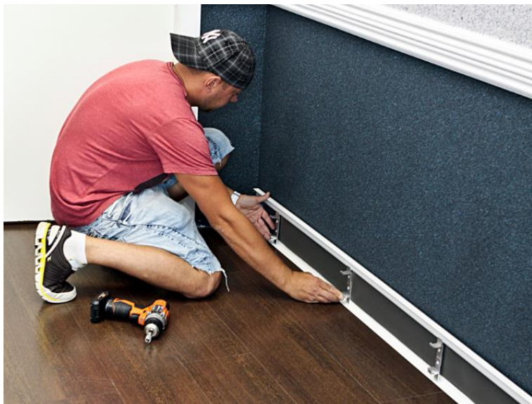
Рис. 15. Верхняя планка с кронштейнами
